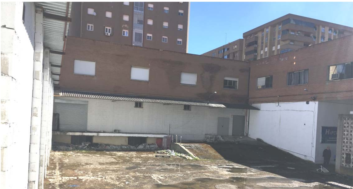
Fotografía de la zona de muelles de carga y descarga existente en el interior de la parcela.
