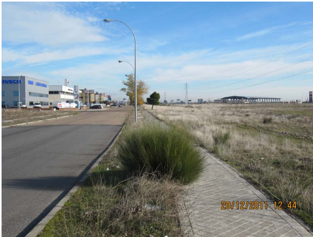
Vista desde el polígono industrial Torrehierro.
