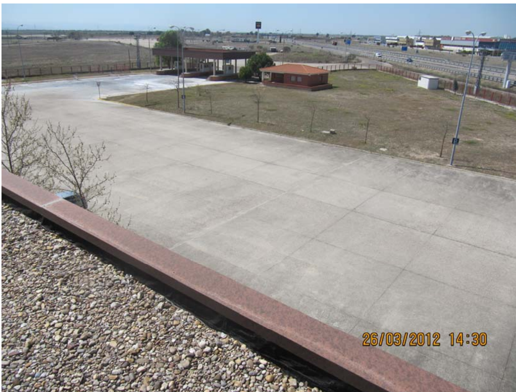
4- Panorámica 1: Sudoeste (autovía)
