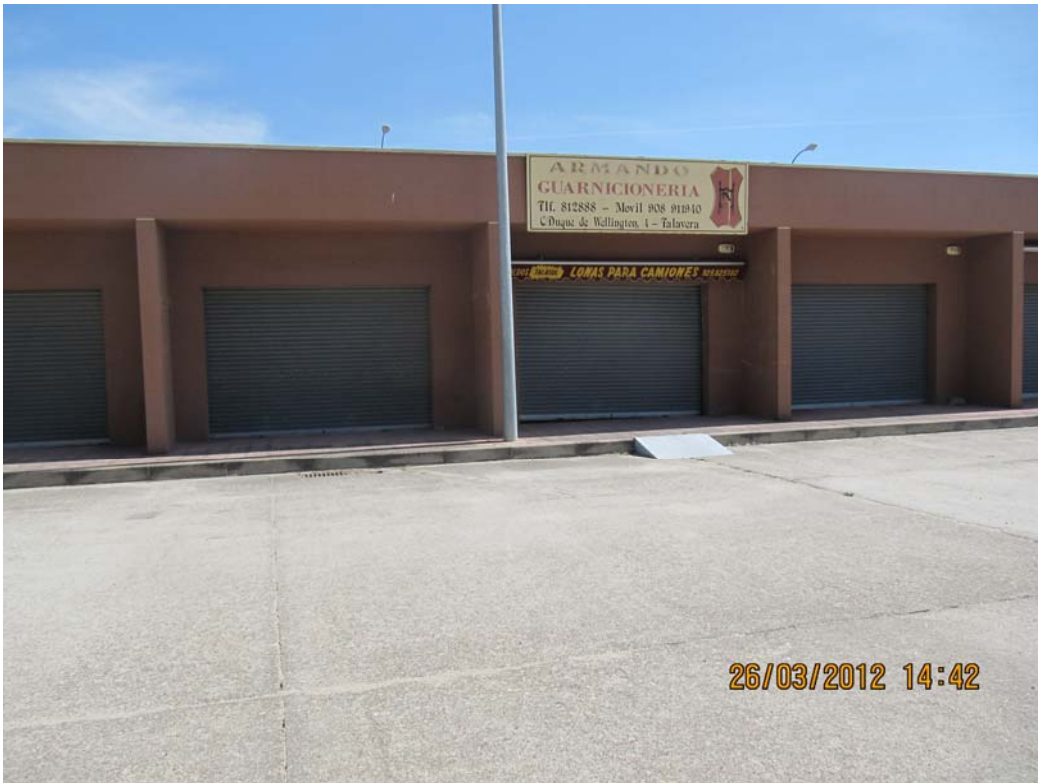
16- Detalle edificio comercial
