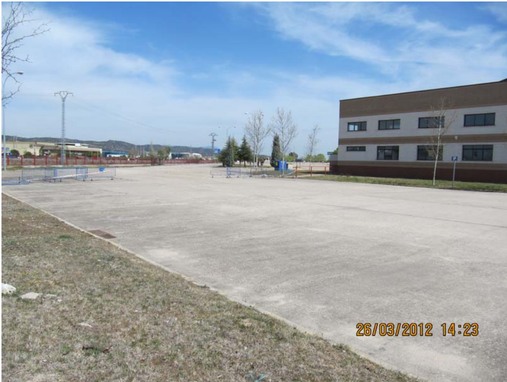
12- Aparcamiento edificio de oficinas
