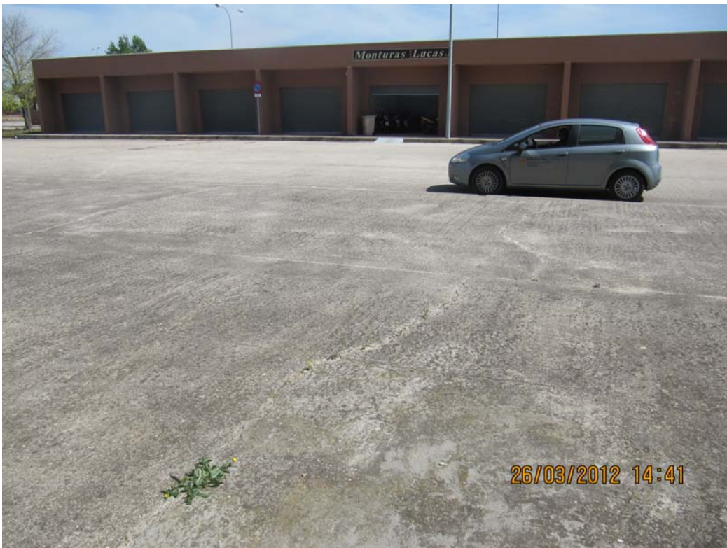
15- Aparcamiento edificio comercial
