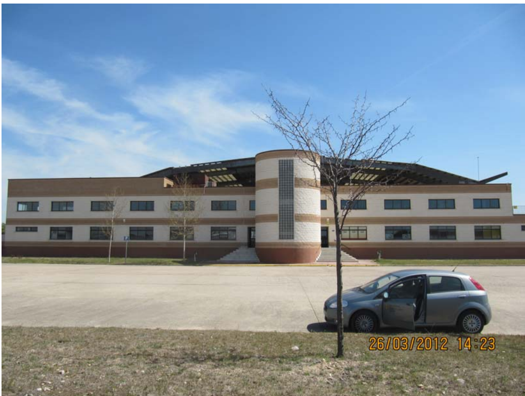
12- Edificio de oficinas
