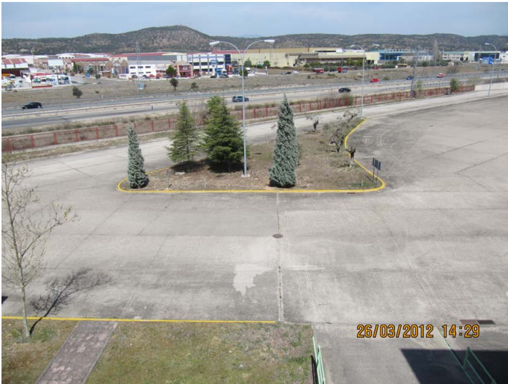
9- Panorámica 6: Norte (autovía y polígono industrial)
