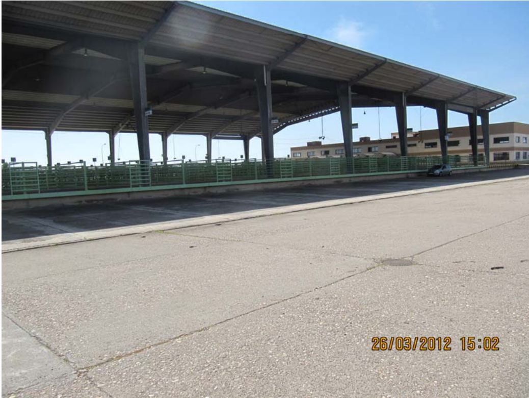
28- Nave mayor (por el coche se aprecia la escala)
