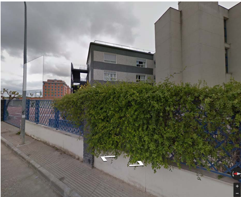
PARCELA 14, DESDE CAMINO DEL PILAR. RESIDENCIA DE MAYORES "EL LUCERO"
