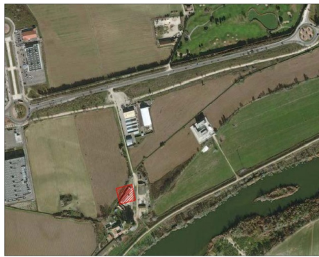
Edificación agrícola, actualmente en uso.
