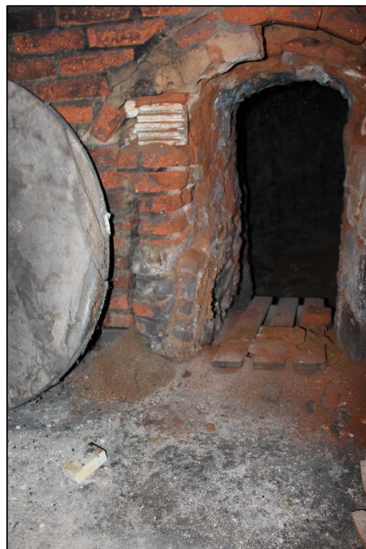
Parte posterior del horno, o zona del "echadero" Restos de vitrificación en las paredes de la cámara de combustión
