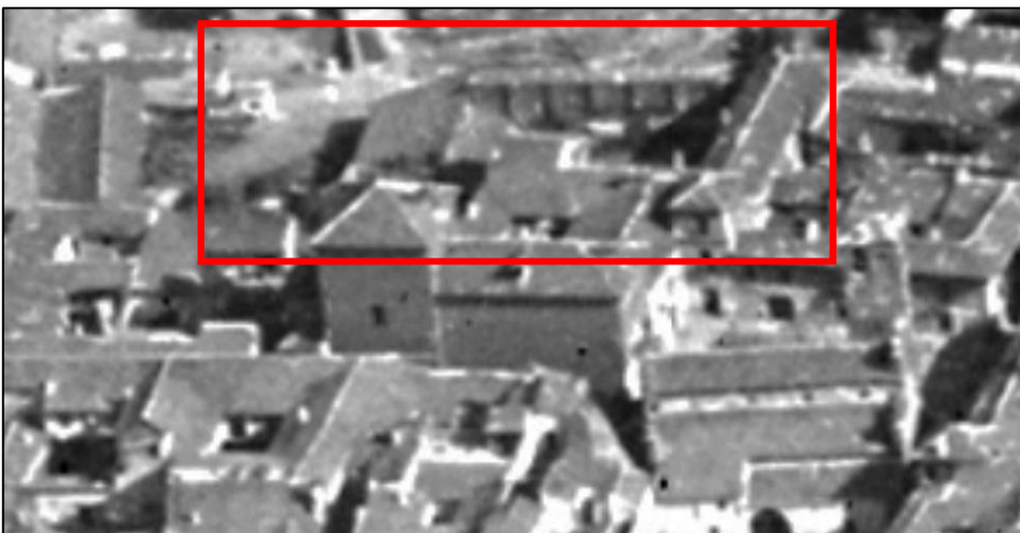
Zona del antiguo claustro conventual y estancias anejas convertidas en casa de vecindad y talleres en la segunda mitad del siglo XIX. (Foto aérea de 1930)
