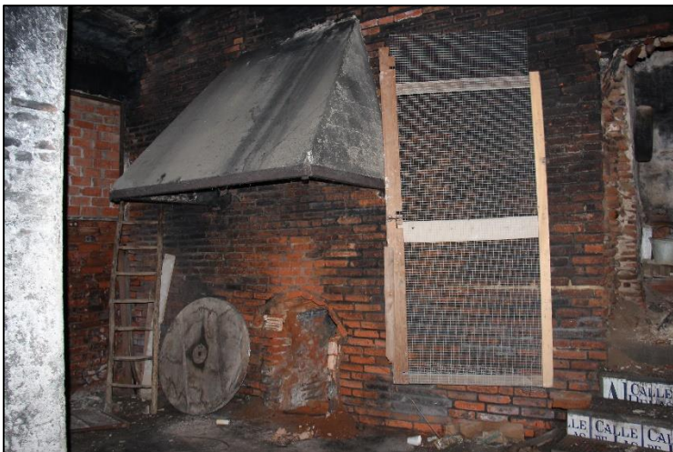
Parte posterior del horno, o zona del "echadero" Restos de vitrificación en las paredes de la cámara de combustión
