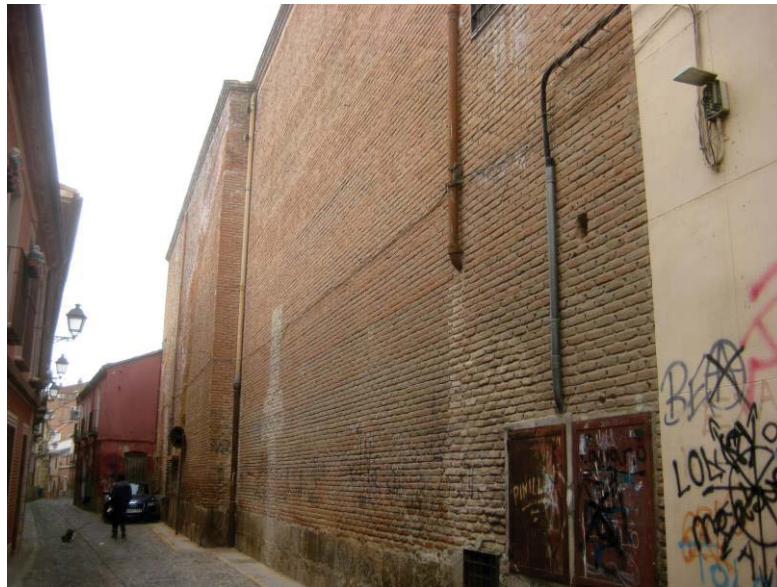
Fachada lateral con la fábrica de la iglesia del antiguo convento de Santa Ana. Foto SRG abril 2016
