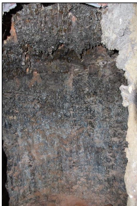
Parte posterior del horno, o zona del "echadero" Restos de vitrificación en las paredes de la cámara de combustión
