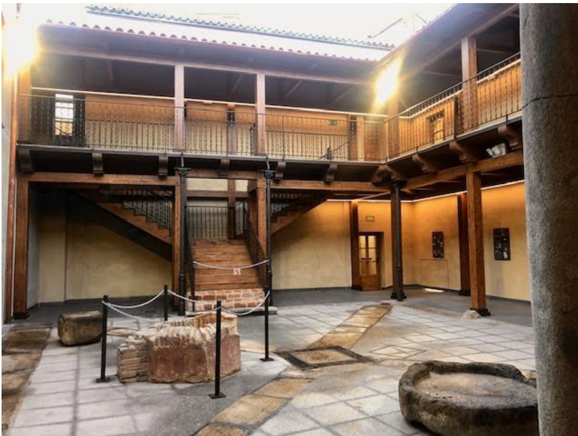
Graf 16 Casa patio en calle Vicaria Vieja. Recientemente rehabilitada
