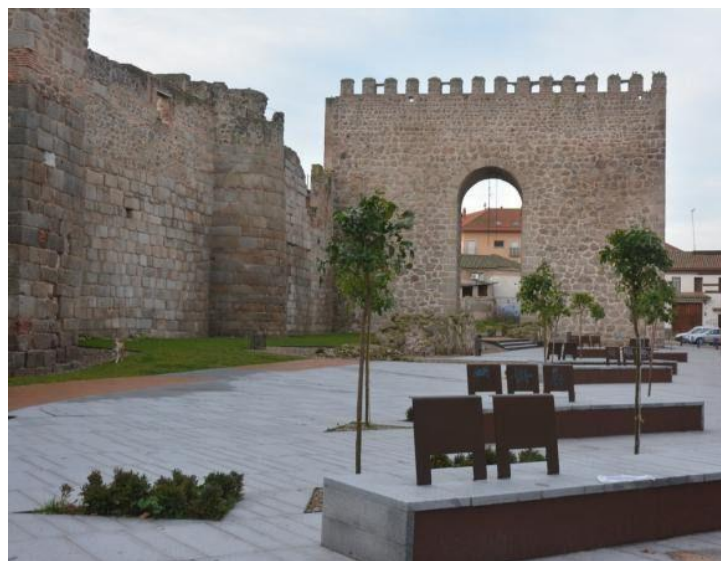
Graf 26 Muralla en calle Charcón, consolidación y restauración
