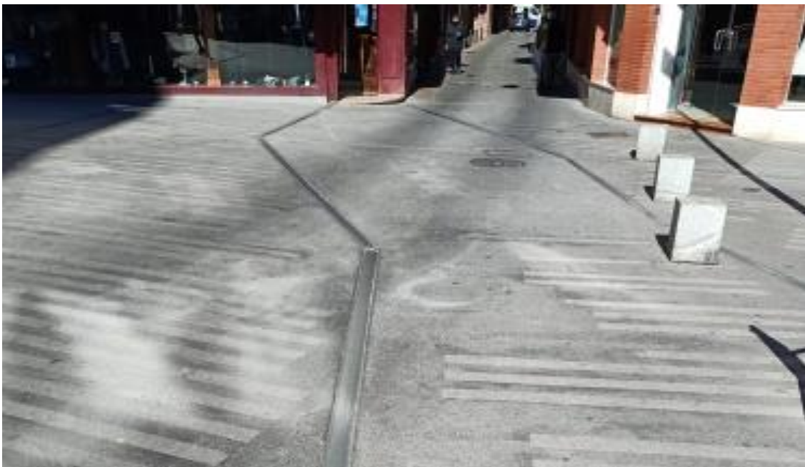
Graf 52 Nuevos pavimentos de diseño actual en Reloj, Corredera y otras zonas, con proyecto unitario. Hormigón gris con franjas geométricas blancas.
